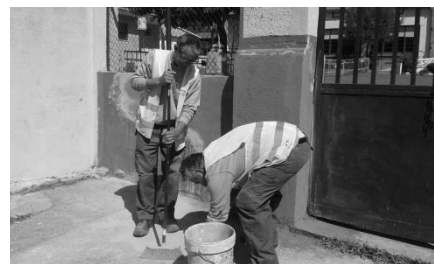
Treballs de millora a l'escola
